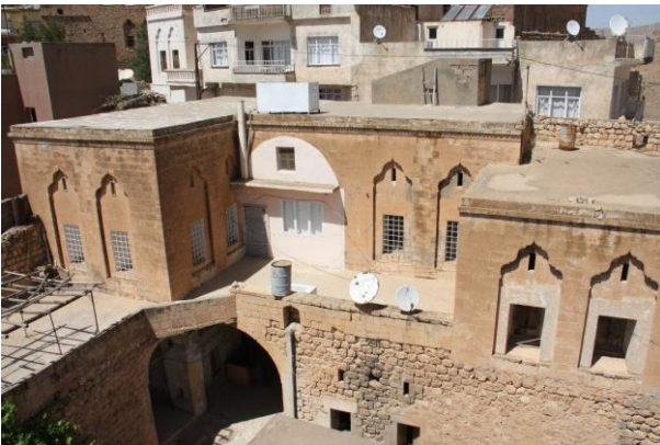
Fotoğraf 69. Hakkı Aytaç Evinin Güneybatı Cephesi (Fotoğraf: İ. YILDIZ)
